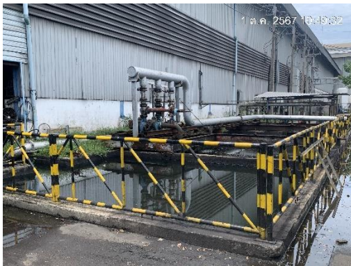
รูปที่ 9 ระบบแยกน้ำ-น้ำมันจากระบบหล่อเย็น
