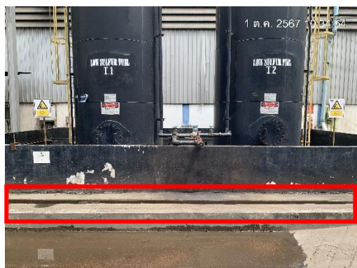
รูปที่ 24 รางรับน้ำรอบพื้นที่กักเก็บถ่าน
