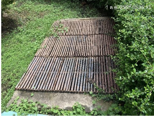
รูปที่ 25 บ่อดักไขมันบริเวณพื้นที่กักเก็บถังน้ำมัน
