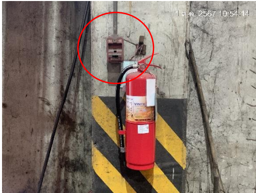
ระบบสัญญาณแจ้งเหตุเพลิงไหม้แบบมือกด
