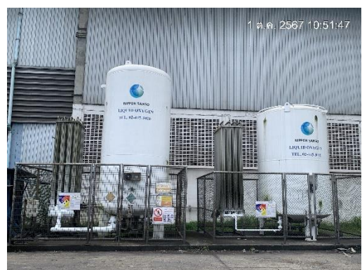
รูปที่ 51 การกักเก็บออกซิเจนเหลวในพื้นที่โครงการ
