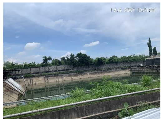
รูปที่ 12 บ่อดักน้ำสุดท้ายขนาด 9,000 ลบ.ม.
